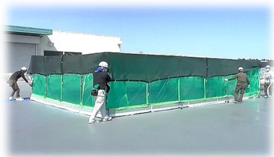
スプレーボックス工法
