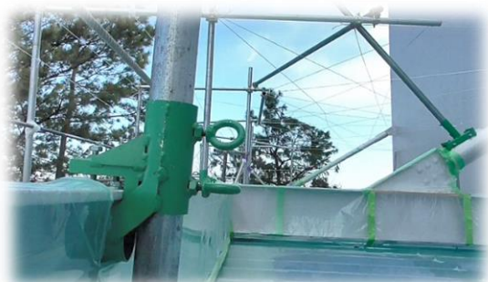
フランジキャッチ工法
