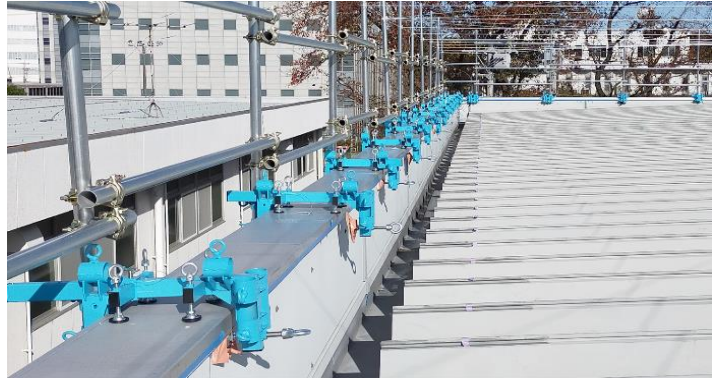
単管囲い込み
