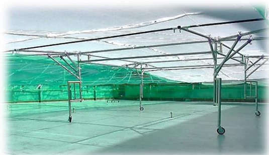
ターンテーブル工法
