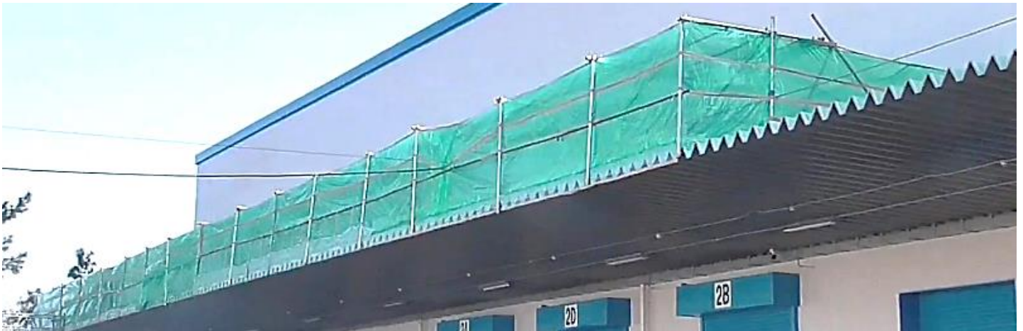
飛散対策（折板屋根根庇）
