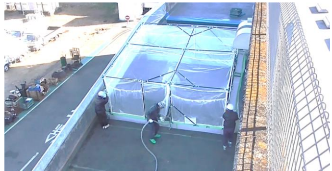
駐車場スロープ
