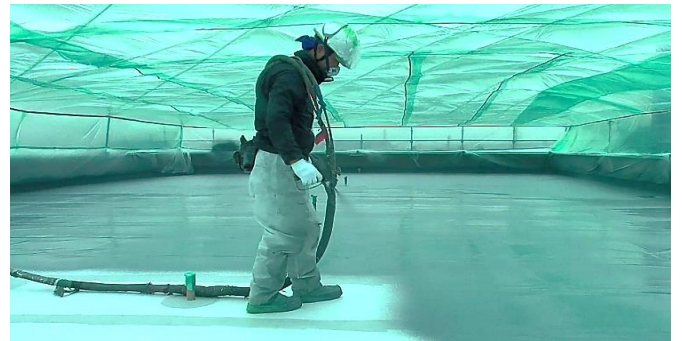
ノンスリップマスキング隔離養生
